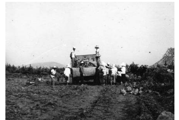
사진 237 새마을 사업(도로 공사)(마을회 제공)
