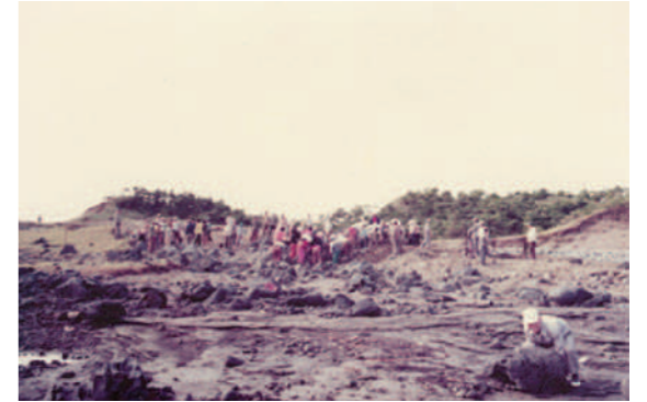
사진 242 새마을 사업으로 해안가 해수방지를 하기 위해 댐을 쌓은 모습(마을회 제공)
