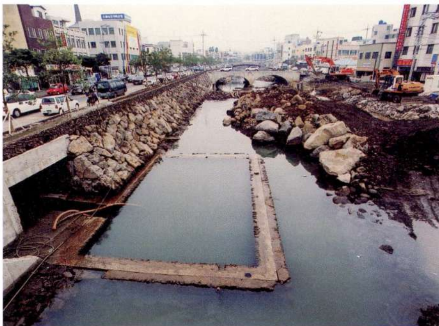
그림 2-10. 산지천 하구 복개구조물을 철거하고 복원공사할 당시 모습
