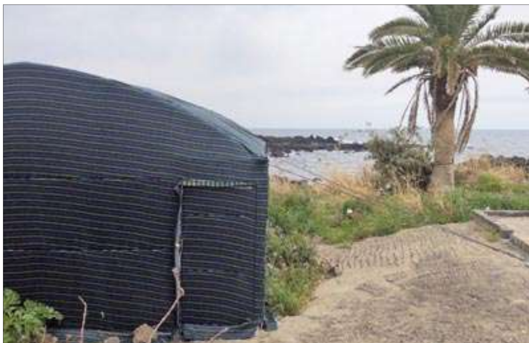
2. 토산리 알당 측면(토산 포구)
