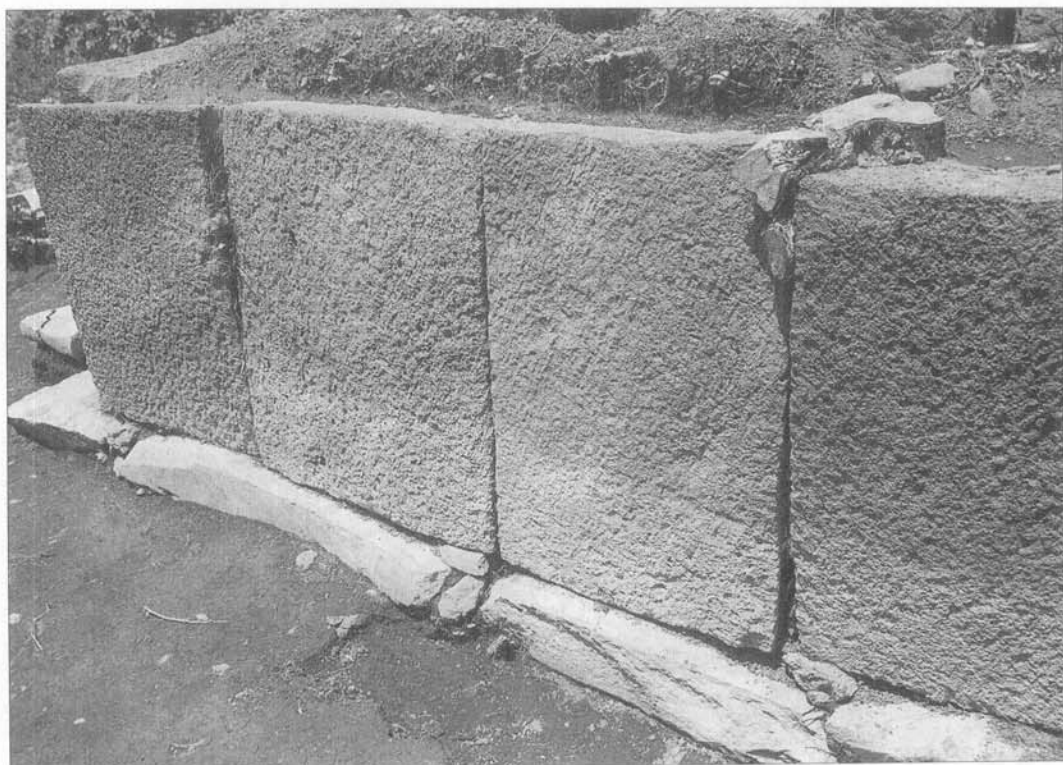
사진 24. 1호분 석곽 동벽 축조 상태
