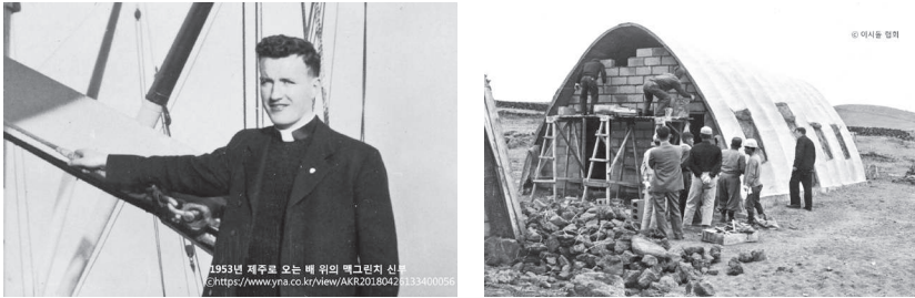
〈그림 1-2〉 맥그린치 신부와 이시돌목장 테쉬폰 주택 시공과정
