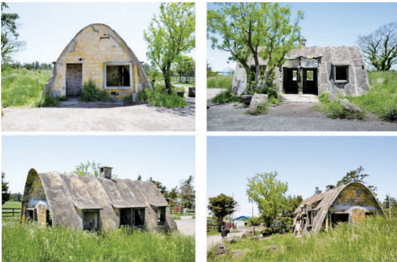
〈그림 2-17〉 ⑤ 금악리 135번지, 직원용 2호 연립 테쉬폰 구법 건축물현장사진
