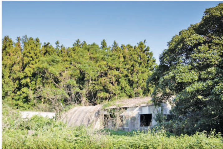
〈그림 2-15〉 ④ 금악리 361-3번지, 주거용 이중 외피 테쉬폰 구법 건축물 현장 사진
