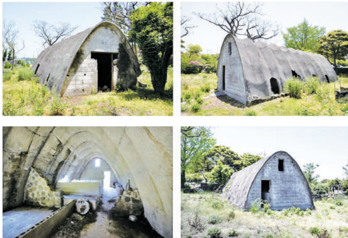
<그림 2-9> ① 금악리 1168-1번지, 창고 테쉬폰 구법 건축물 현장사진
