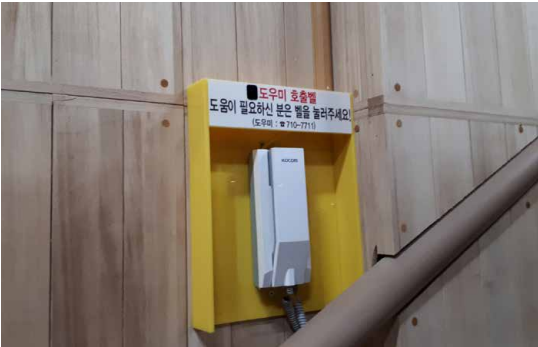
제1민속수장고 호출벨 설치
