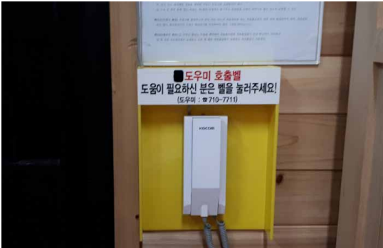
제2민속수장고 호출벨 설치
