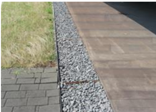
<그림 5-24>제주 스페이스 닷원 트렌치 위 자갈마감 배수로
