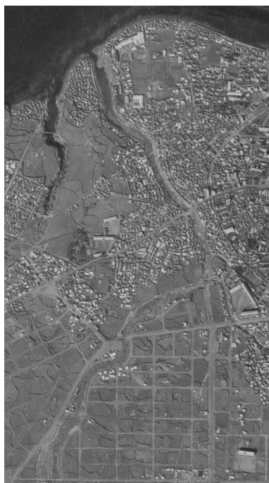
〈그림 13〉 제주시 병문천 복개 전 위성사진(1969년)_출처:국토지리정보원 국토정보플랫폼
