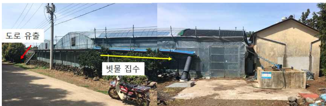
[사진 Ⅲ-1] 시설하우스 빗물 집수 및 도로 배수
