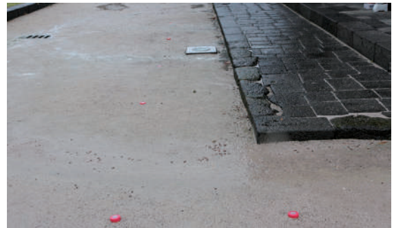
주변부에 설치된 군체제거시스템
