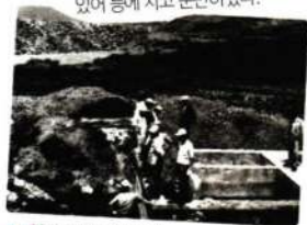
▲ 여승생 저수지 공사
