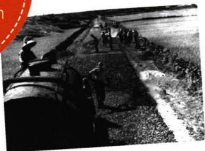
▲ 우회도로 포장공사 사진은 구좌읍 하도~종달 우회도로 포장공사 현장. 1960년대는 각종 도로개발을 비롯한 용수개발, 전기·전화사업들이 활발히 추진됨.
