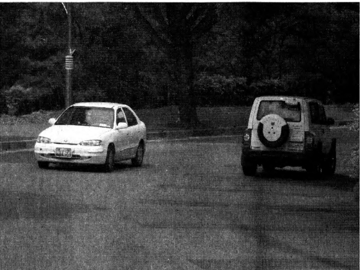
인문대 옆 커브길은 중앙선이 거의 지워져 있어 비가 오거나 안개가 끼는 날이면 사고 위험이 높다.
