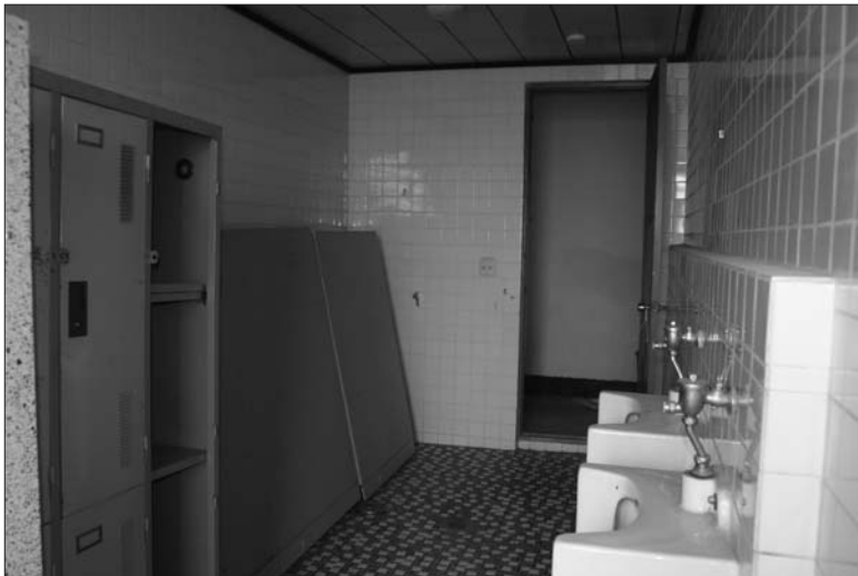
체육관 여자탈의실 내부모습. 여자탈의실이라는 뜻말이 붙어있긴 하지만 전에는 남자 화장실이었다.
