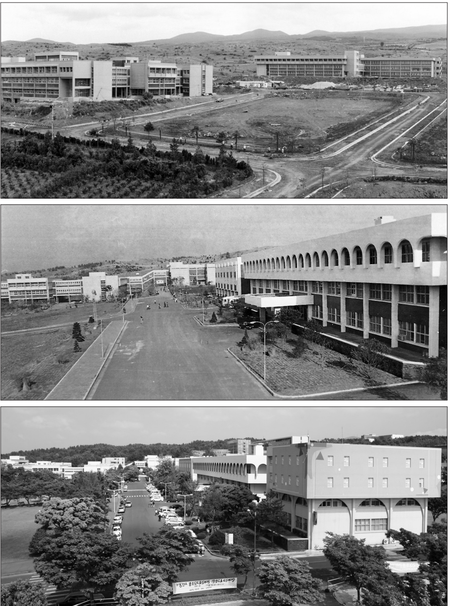
1978년 아라동 캠퍼스 공사현장으로 허허벌판 위에 건설중인 대학건물과 도로가 눈에 띈다(위). 1982년 3월 1일 종합대학 승격 후 캠퍼스 모습. 본관과 대학원동, 생명자원과학대학과 해양과학대학이 보인다(가운데). 현재의 캠퍼스 전경(아래).
