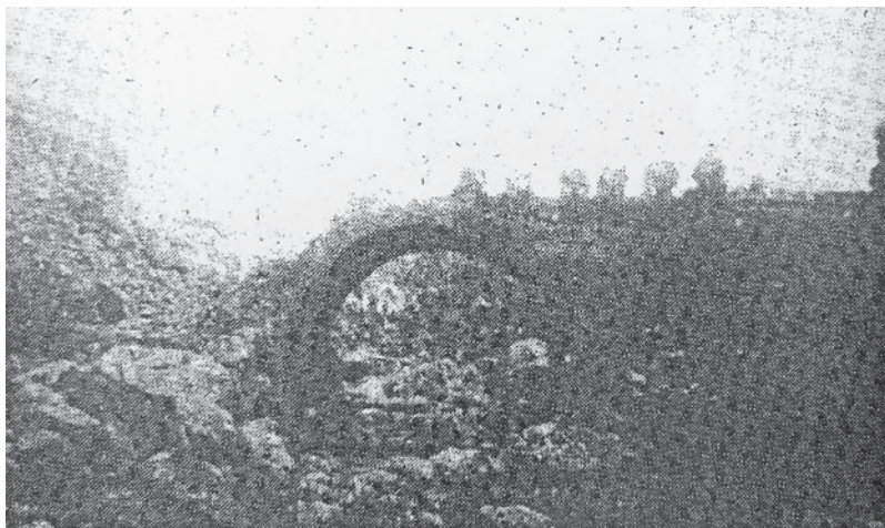
1927년의 홍수로 파손된 뒤의 남수각(南水閣) 홍예교(虹霓橋) | 이 뒤로는 보수하지 않고 그대로 방치되었다.
